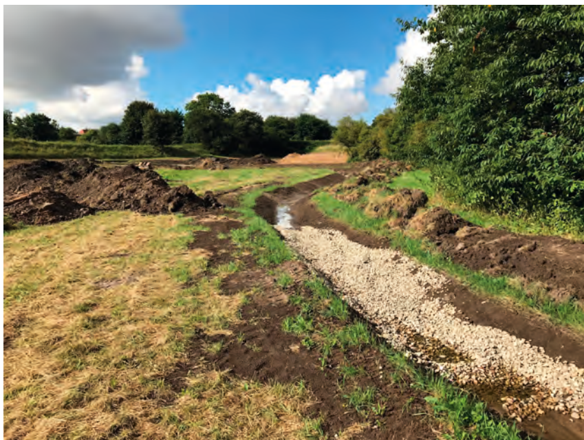
Det nye vandløb august 2020. Grus- og stenbunken forrest i billedet er en gydebanke.
